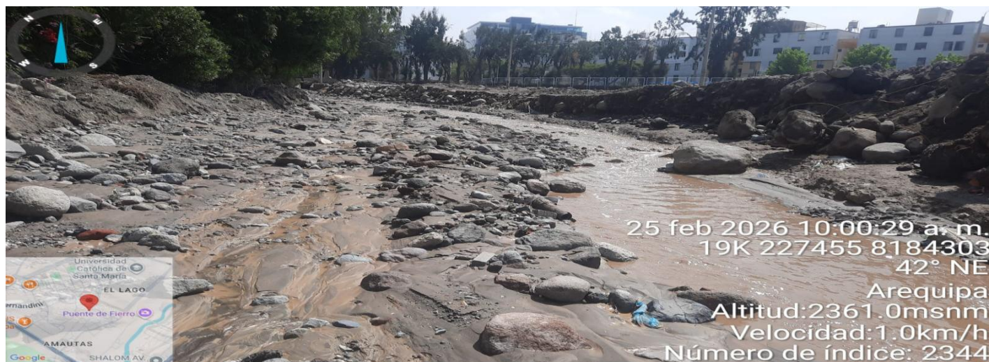
IMAGEN 02: SE OBSERVA EL CAUCE DE LA QUEBRADA CHULLO HA SOCAVADO EN ESTE TRAMO SU MARGEN IZQUIERDA, QUE PERTENECE AL DISTRITO DE AREQUIPA, Y ENCUYA CAJA HIDRÁULICA SE ENCUENTRA COLMATADO DE PIDERAS MEDIANAS Y LODO;
